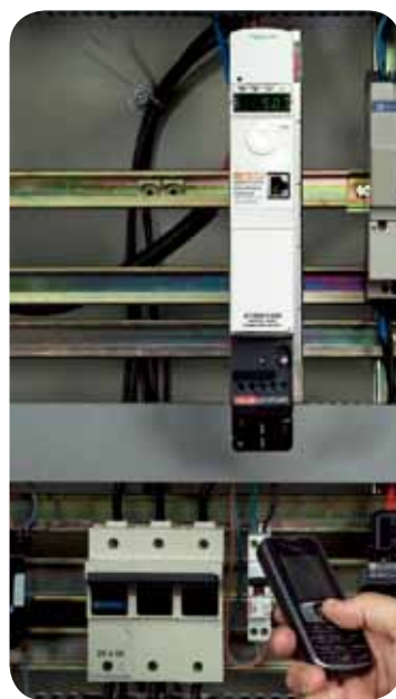
内置蓝牙®连接: 可简化配备蓝牙®的产品间的通信
