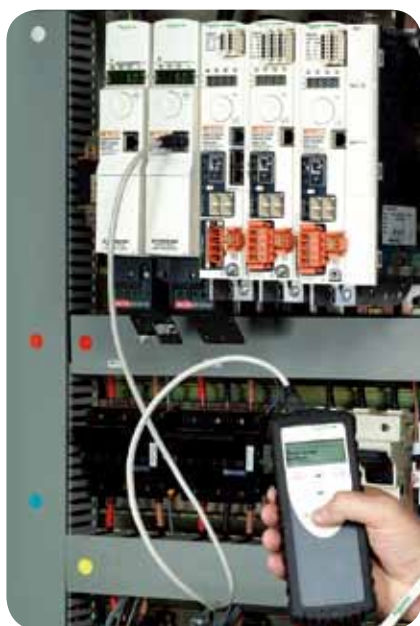
Multi-Loader: 在一张 SD 卡上配置并保存多台变频器的配置文件
