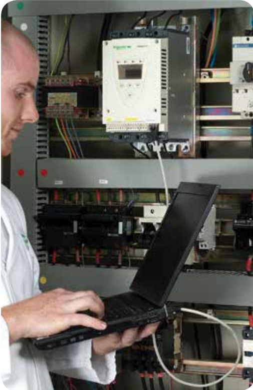
采用SoMove lite设置软件对ATS 22软起动-软停止单元进行配置
